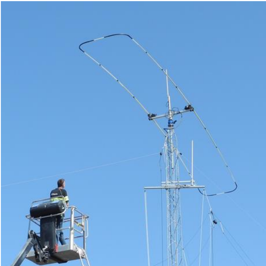
Bilde 7, buene er ferdig montert og antennen er nå bedre enn som ny
