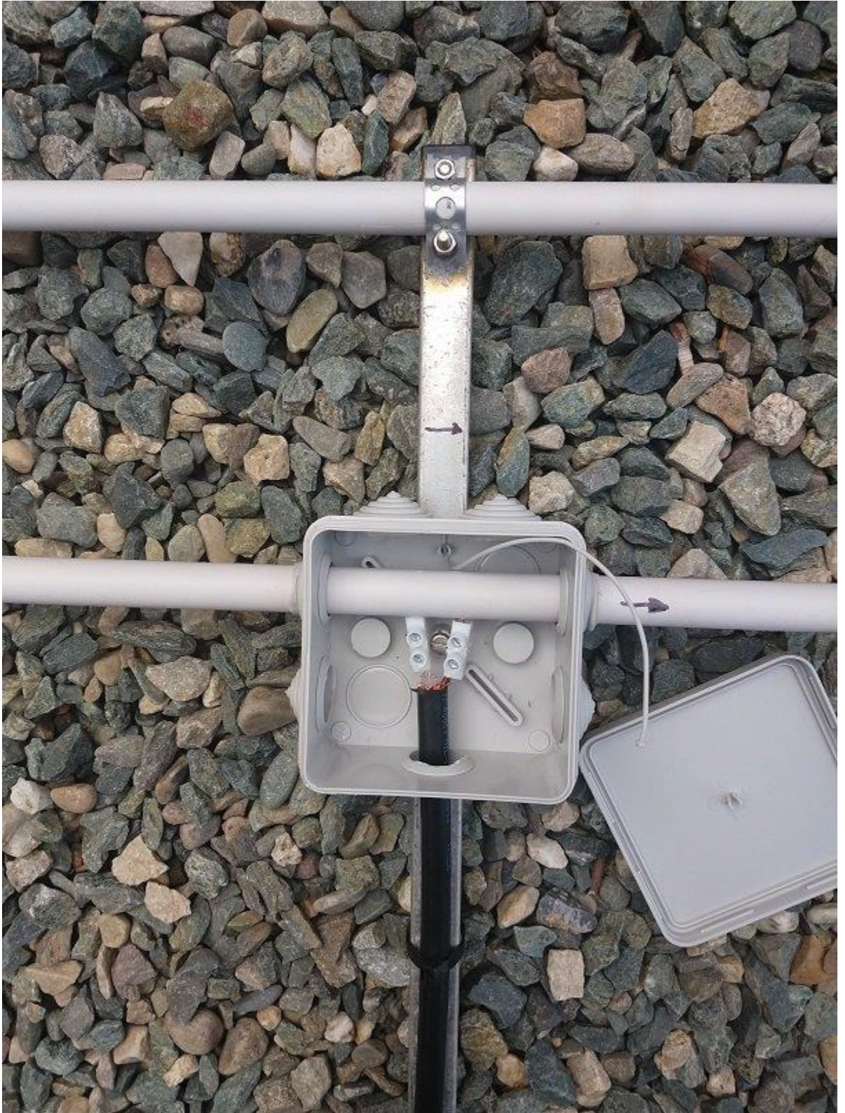
Bilde 2, Tilkobling av RG-63 koaksialkabel til antenneledningene. Disse kan gjerne loddes.
